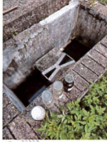
生活污水排放口
