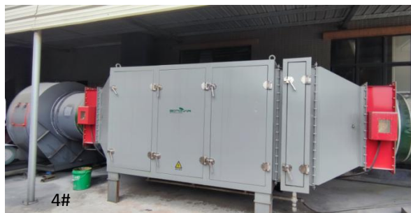
图 1 静电式烟雾净化器(3#生产线及 4#生产线)
