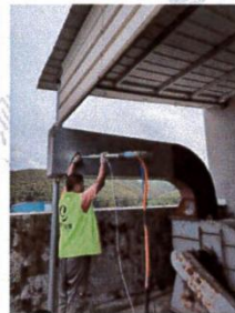
DA006 废气排放口
