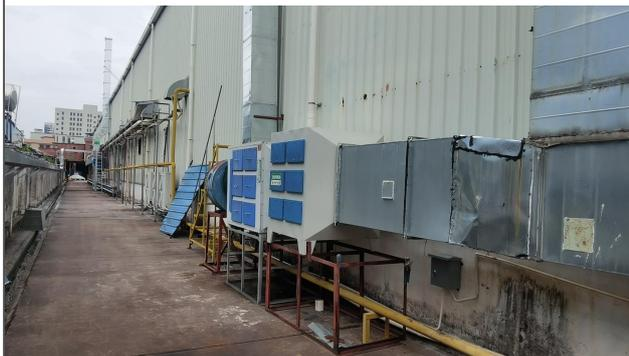
图3 吹瓶车间废气处理设施
