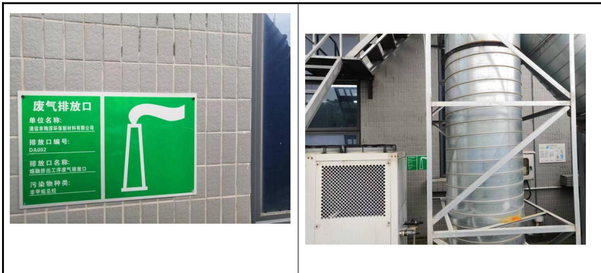
图 7 熔融挤出工序废气（含打版注塑机废气）排放口 DA002 标识牌（近、远）
