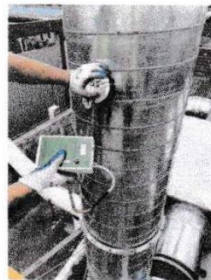
实验室废气 DA010 排放口
